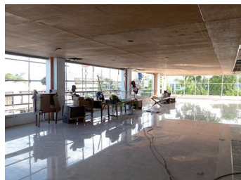
展望ラウンジ(建設中)
